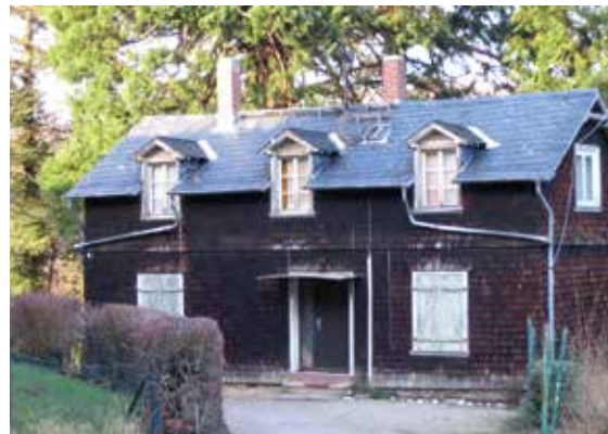
Das Russenhaus vor der Sanierung
