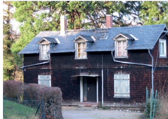
Das Russenhaus vor der Sanierung
