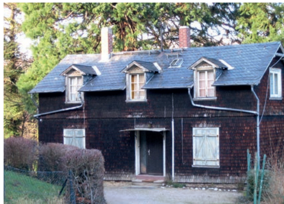
Das Russenhaus vor der Sanierung
